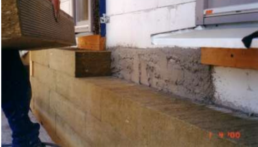
Bild 1 Dämmung der Außenwand an einem EFH mit Mineralwolle, s = 30 cm
