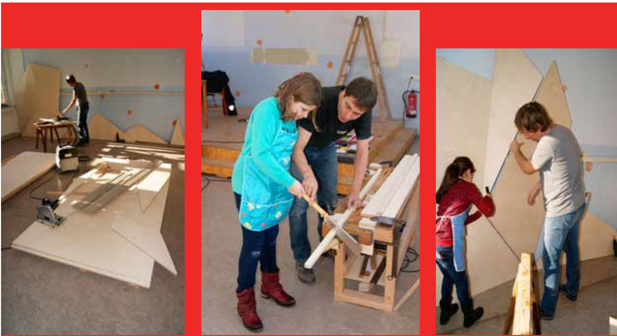
1/Die Wandverkleidung wächst und wächst..2/Meta sägt die Leisten mit japanischer Handsäge zu 3/ Beritan hilft beim Anpassen und Befestigen der Teile an der Wand
